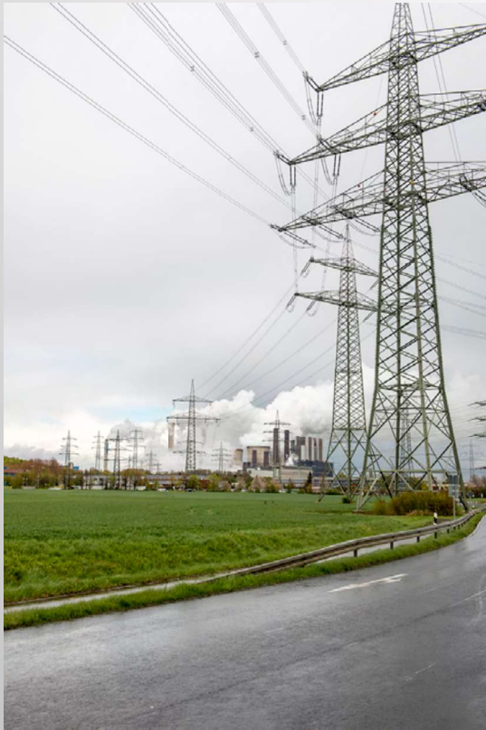
Kraftwerk Weisweiler (April 2016)
