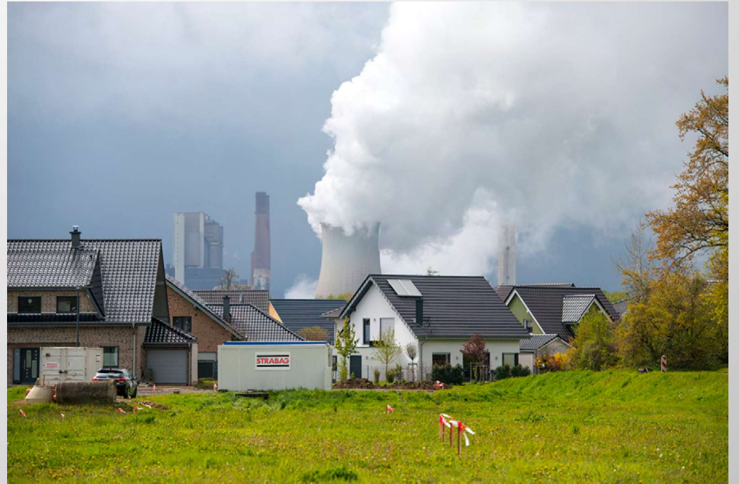
Wohnen am Kraftwerk Weisweiler (April 2016)
